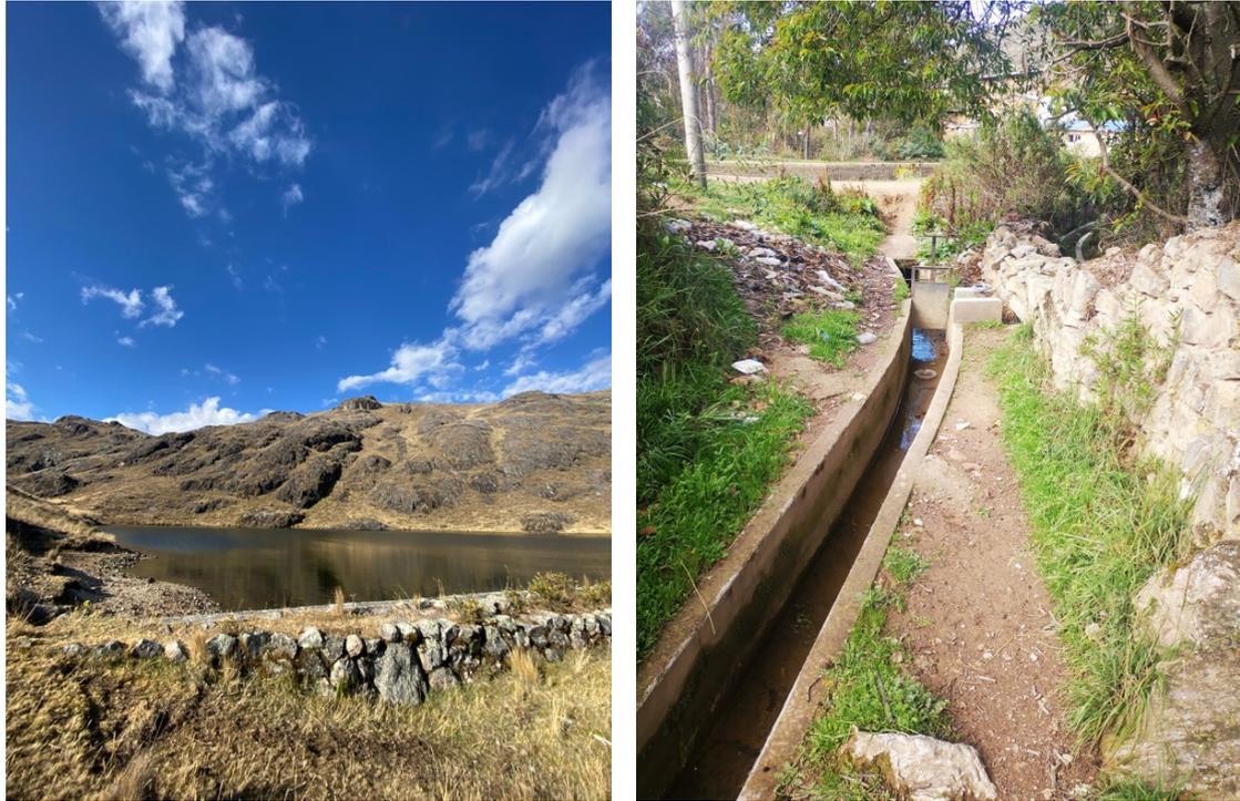
*Figura 3 : A la izquierda, una cocha construida en altura para captar las aguas de lluvia; a la derecha, un canal de concreto conduce el agua recolectada hacia los campos en la parte baja (fuente: Autora).*
