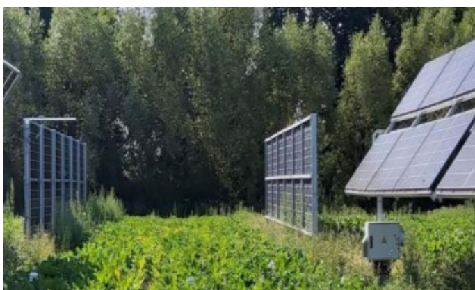
Système bifacial vertical et tracker à axe unique sur le site de Grimbergen
