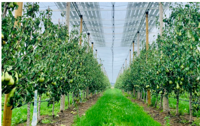
Projet expérimental de panneaux solaires à modules de feuilles transparentes et des cellules classiques de silicium au-dessus d'un verger de poiriers à Bierbeek, Belgique 4
