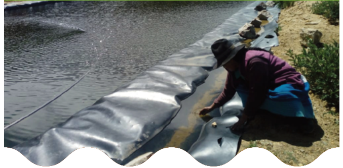
Ajustes finales durante la instalación de una geomembrana de un embalse para riego (Aija, Perú)
