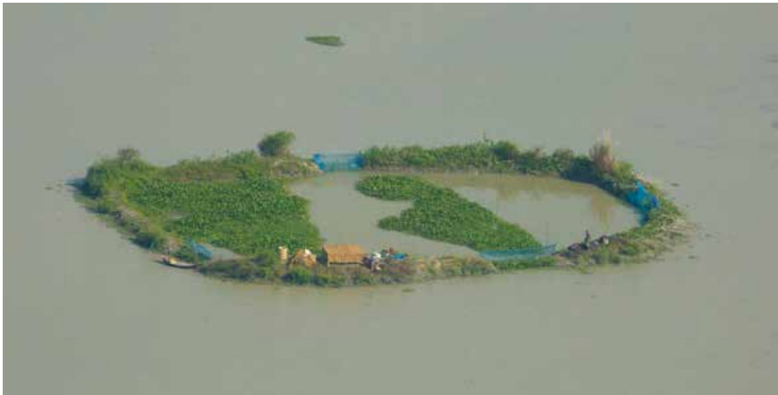
DIGUES AUTOUR DES VILLAGES
